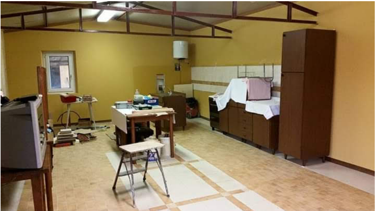
IL RISULTATO OTTENUTO DOPO I LAVORI DI AMMODERNAMENTO RIVESTIMENTO DELLE PARETI CON PANNELLI DI CARTONGESSO TINTEGGIATI PAVIMENTAZIONE IN PIASTRELLE LAVABILI IMPIANTISTICA e FINITURE
