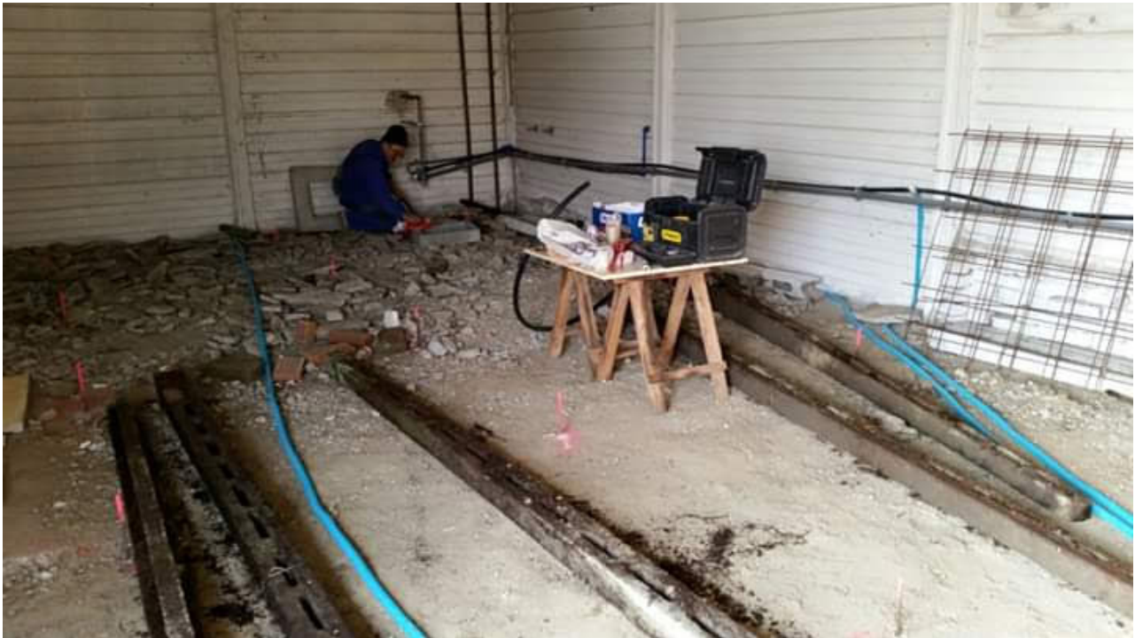
QUANDO SONO STATI FATTI I LAVORI DI AMMODERNAMENTO
