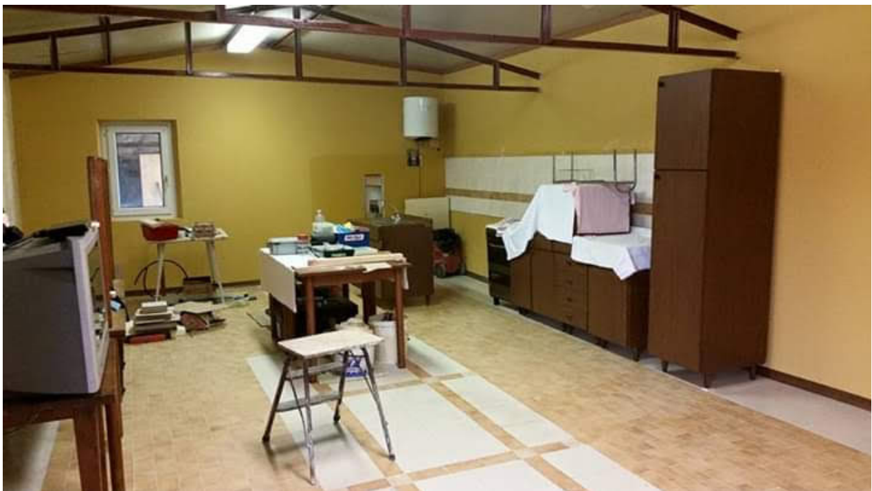
IL RISULTATO OTTENUTO DOPO I LAVORI DI AMMODERNAMENTO RIVESTIMENTO DELLE PARETI CON PANNELLI DI CARTONGESSO TINTEGGIATI PAVIMENTAZIONE IN PIASTRELLE LAVABILI IMPIANTISTICA e FINITURE
