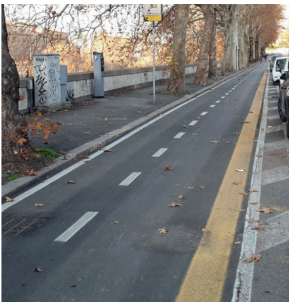
Uno dei nuovi percorsi ciclabili della capitale sul Lungotevere (foto Legambiente)
